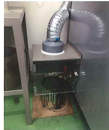
② 抽出後のAS抜き(ドレーン)に吸気BOXを設置
