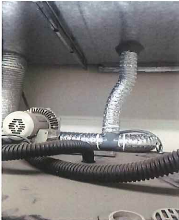
③ 装置上部で連結させダクト設備に排出
